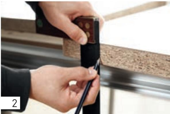
Übertragen Sie die Markierungen auf die Stoßflächen der Arbeitsplatte – es genügt dies dort zu tun, wo Sie später die Flächenverbinder einsetzen möchten.
