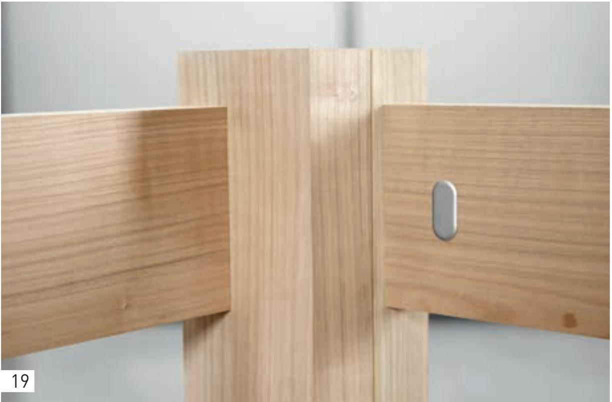
So entsteht schnell, ohne aufwendiges Messen oder Anzeichnen eine stabile Verbindung, die bei Bedarf schnell wieder lösbar ist.
