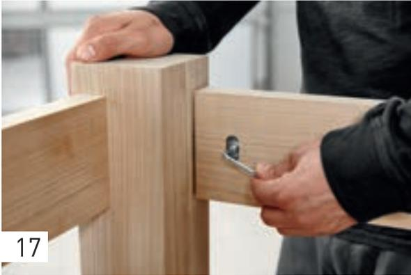
Verbindung mit einem 4-mm-Inbusschlüssel festziehen.
