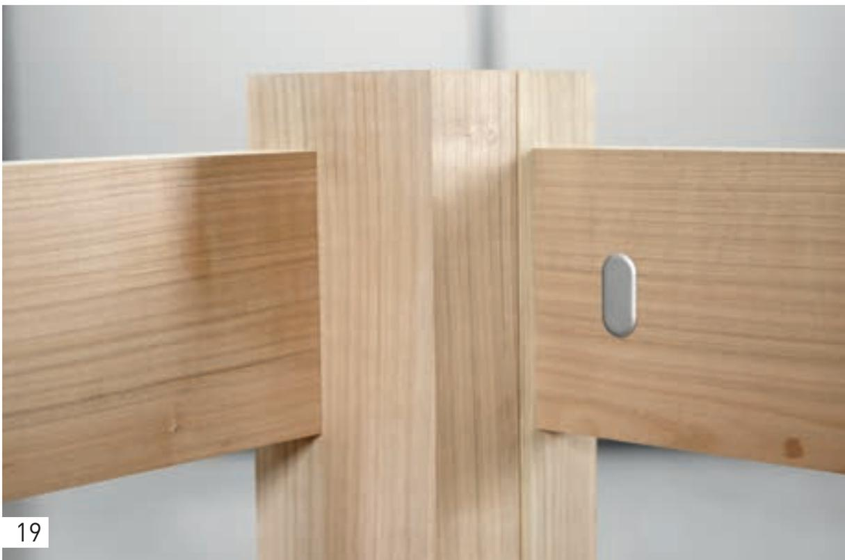
Il en résulte rapidement, sans mesure ni marquage complexes, un assemblage stable qui peut être à nouveau démonté rapidement si besoin.
