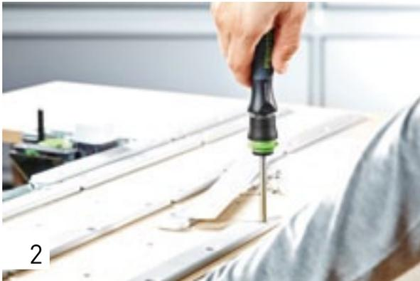
A continuación, monte la placa adaptadora y las placas deslizantes según el manual de instrucciones. Las placas deslizantes facilitan el guiado de la pieza de trabajo sobre la mesa. Se suministran 15 unidades con la placa adaptadora. Si necesita más placas deslizantes, podrá adquirirlas como accesorios.
