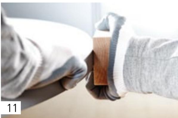
Termine a junta, pressionando o rebordo com um taco de madeira.
